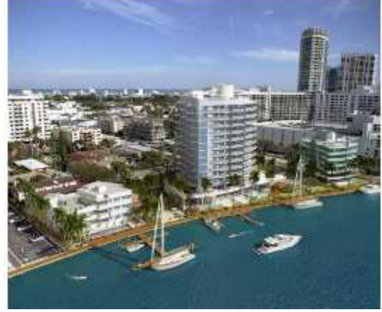
Resim 20 The Capri, Miami Bay, ABD. Penetron Admix uygulanmış bodrum yapısı
